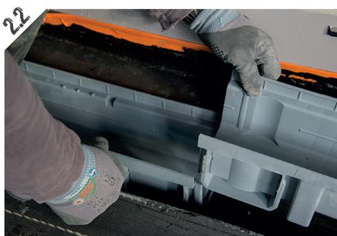
Assembler les corps de caniveaux sur la semelle béton en tenant compte du raccordement Mâle/Femelle.
