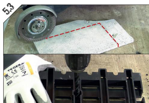
Présenter la grille sur un élément de revêtement et en délimiter le contour. Découper le revêtement pour l'ajuster à la bonne dimension. Percer un trou diamètre M8 dans l'axe du/des logement(s) d'écrous hexagonaux.
