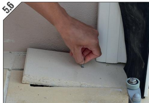
Coller le revêtement en s'ajustant au verso de la grille et en s'assurant que les perçages sont bien dans l'axe.
