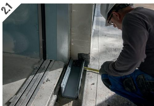
Positionner les éléments de corps de caniveaux (CAB773, CAB134, CAN177) sur la semelle béton. Veiller à l'alignement et au centrage des corps.
