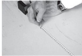
2. Reporter la position de l'axe du manchon sur la plaque de plâtre, y positionner le gabarit joint dans l'emballage et tracer la découpe.
