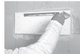
8. Arrivé en butée, il ne reste plus qu'à nettoyer le surplus de mortier et la façade.
