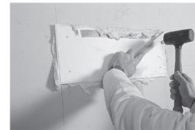
7. A l'aide d'une cale de protection, enfoncer fermement le caisson au marteau. Les angles crénelés s'incrudent dans le plâtre.
