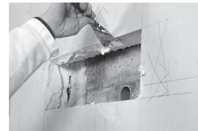
5. Enduire largement les parois internes du doublage de mortier adhésif sauf au passage de l'emboîture. Même chose pour le caisson, seuls les angles crénelés ressortent des faces.
