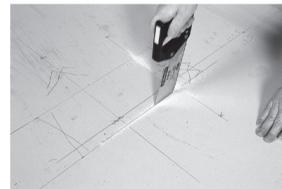
3. Découper la plaque et le doublage à la scie. Mettre en place la plaque.
