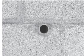
1. Après coupe à l'épaisseur du mur, mettre en place le manchon en traversée de maçonnerie. Quand les enduits extérieurs sont terminés, y clipser la grille à ailettes anti-pluie.
