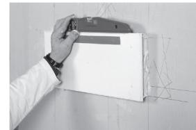
6. Positionner le caisson dans le manchon, vérifier le niveau.
