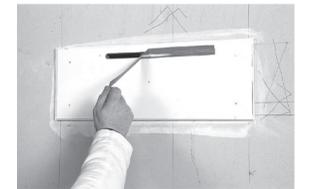
9. Oter la protection de mortaise et fixer le régulateur.
