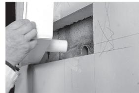
4. Positionner à sec le caisson qui se trouve guidé par la sortie mâle coulissant dans le manchon de traversée de mur. Seul le niveau est à vérifier. Oter le caisson.
